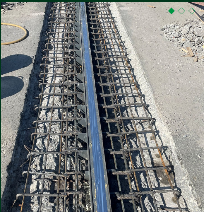
Арматурный каркас ДШ
